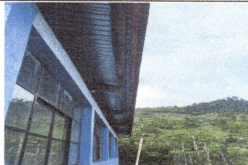
Foto 6: Sustitución de canal de pvc a canal metálico galvanizado con pescantes.
