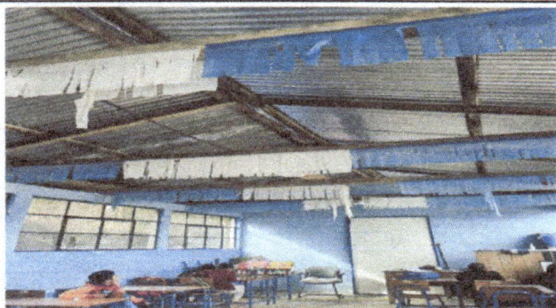
Foto 1: Sustitución de estructura de madera a estructura metálica.
