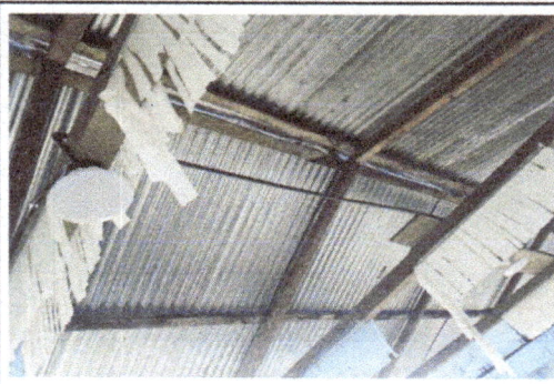
Foto 2: Sustitución de láminas acanaladas a láminas troqueladas calibre 26.
