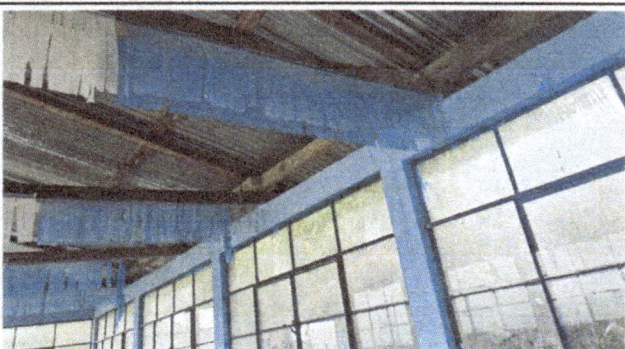
Foto 3: Sustitución de ventanas a ventana balcon aula.
